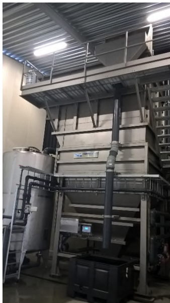
Figuur 15-1: Lamellenseparator (links) en vlokmiddeldosering (rechts).
