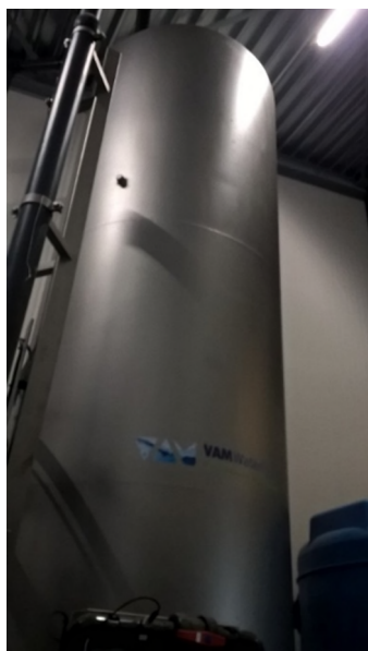
Figuur 15-2: contactvat voor ozon. UV-buis is niet te zien op deze foto maar is linksonder het contactvat. .
