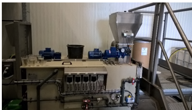
Figuur 15-1: Lamellenseparator (links) en vlokmiddeldosering (rechts).
